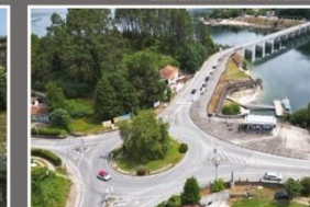
REQUALIFICAÇÃO DE PAREDES - RIO CALDO
